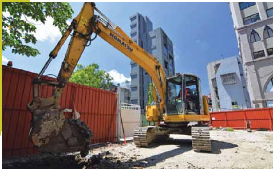
宣教大樓後棟副堂動工
